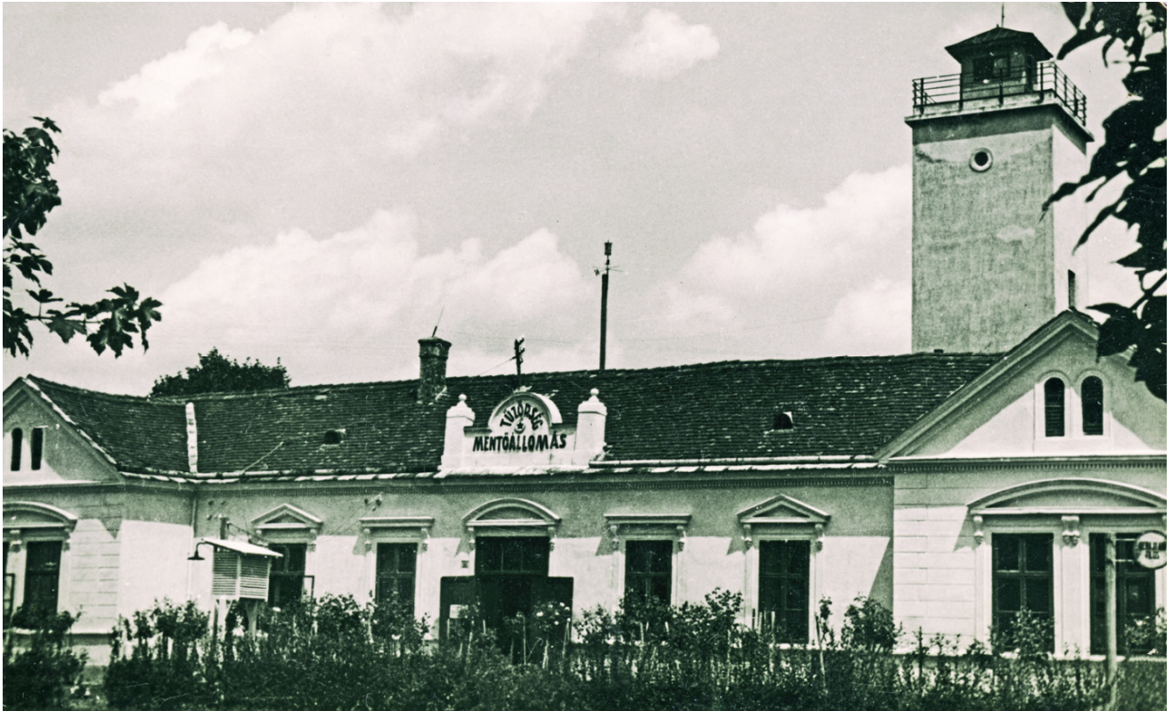
A Nagykánizsai Tűzoltólaktanya és Mentőállomás épülete 1949-ben
