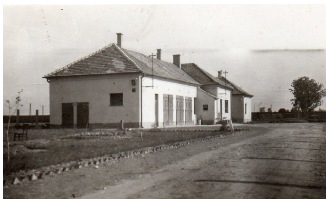
A mentőtelep később mentőállomás céljára átalakított két épülete
