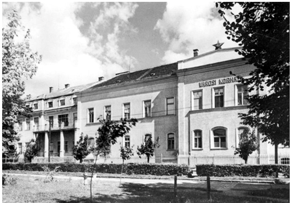
A forradalom első napjaiban a kórház dolgozói a tűzoltóság segítségével levették a kórház főépületéről a képen még látható vörös csillagot
